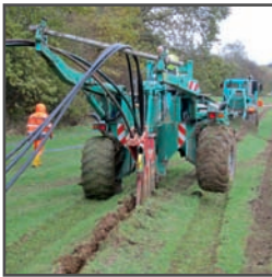
Das Energiekabel wird auf weiten Strecken in den Boden eingepflügt
