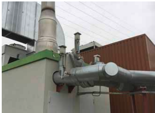
Wärmeauskopplung aus der Biogasanlage mit dem Bypass-System (Bild links) und Anlagenkomponente Generator (Bild rechts)
